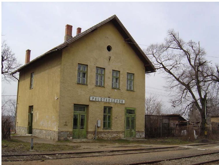
hasznosításra váró állomás épület
